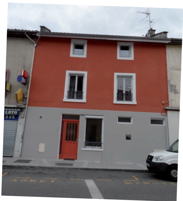
Exemple de façade rénovée à Villard-Bonnot.
