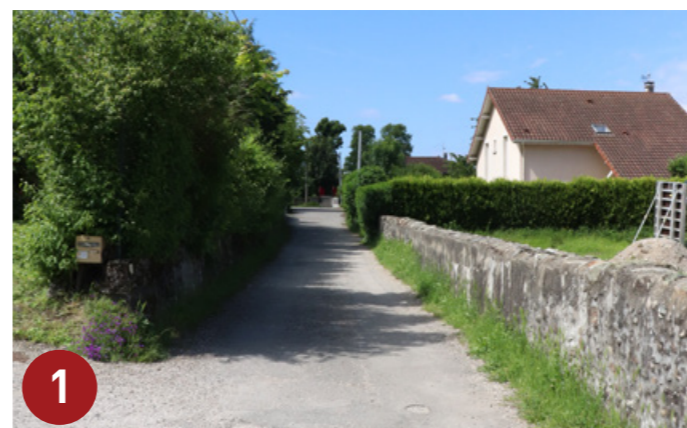
1 Ancien mur en pierre situé à l'angle entre la rue du Martinet et la rue des Béalières
