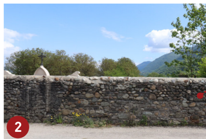
2 Mur de pierre faisant l'enceinte du cimetière de la rue du Cotten.
