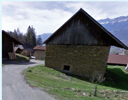
Secteur ouvert à Vautravers
