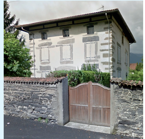
Exemple de maison «bourgeoise» avenue du Grésivaudan
