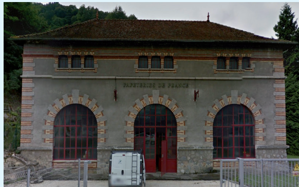
La centrale hydroélectrique
