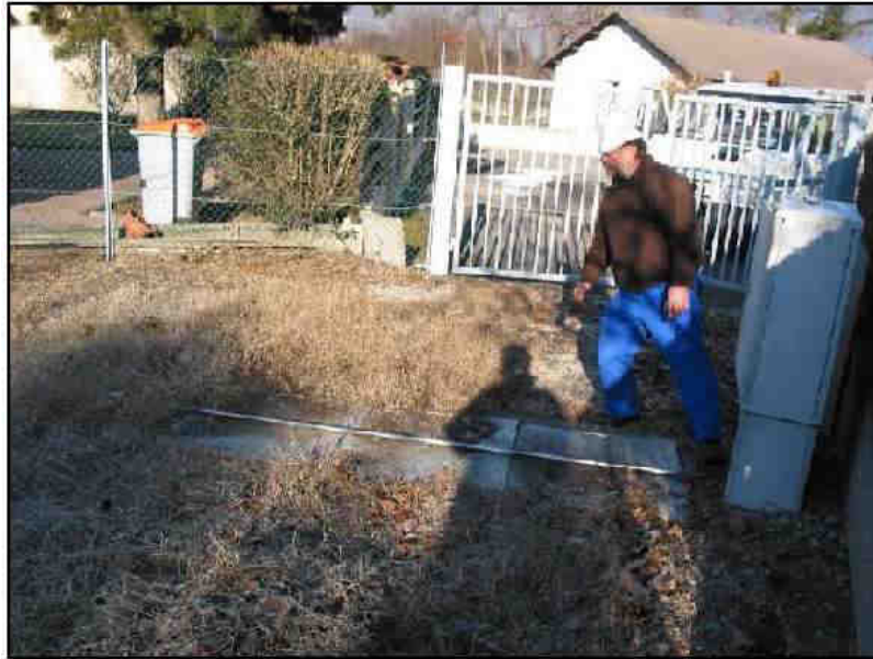
I4- Station de refoulement de Pré Vallet
